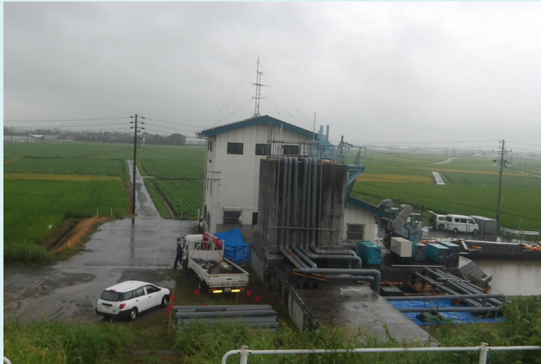
水中ポンプ設置状況 1
