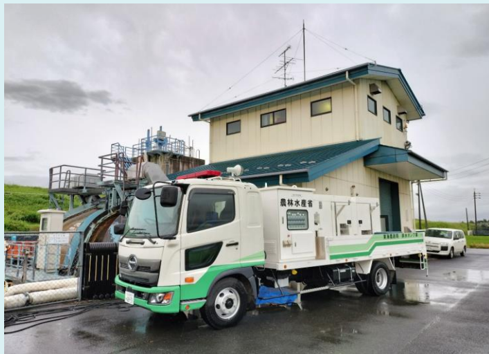
排水機場への排水ポンプ車配置状況
