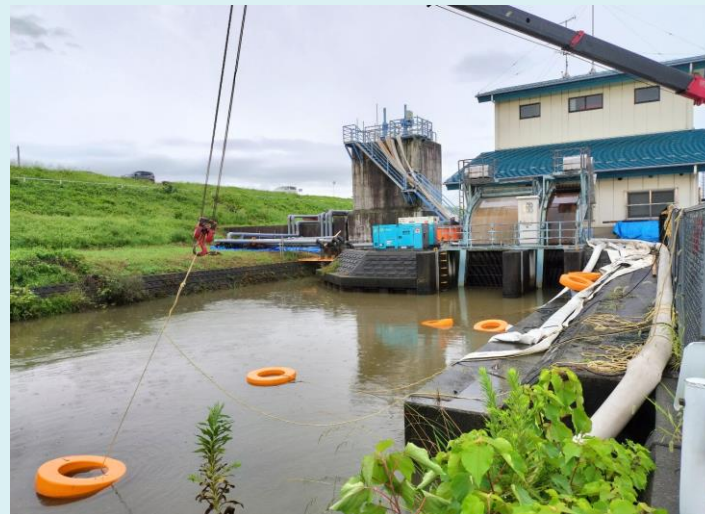
吸水地点における水中ポンプ設置作業状況
