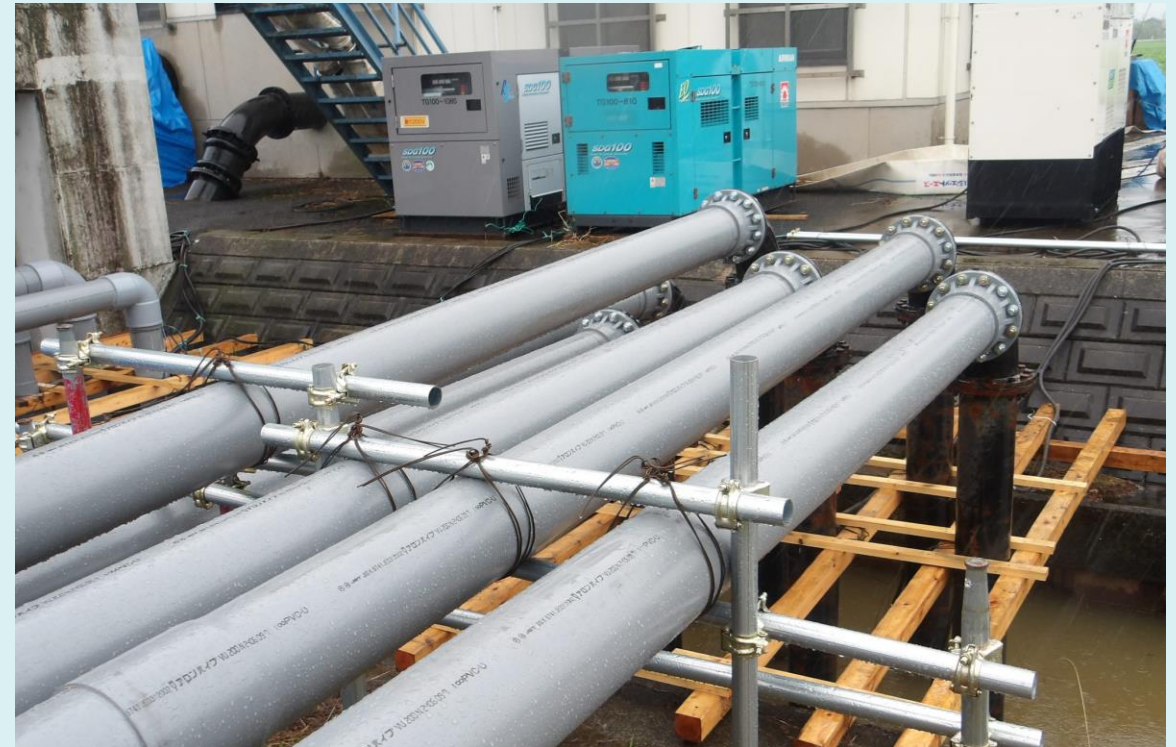
水中ポンプ設置状況 2
